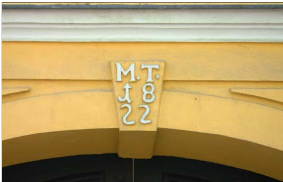
Detail na Točekovskom dome
